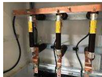
Strongo Mit integrierter Schutzbox mit MS-Sicherungen
